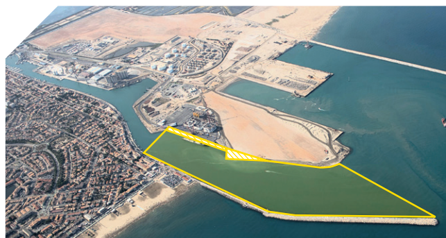
Travaux accès nautiques chenal d'accès sud
