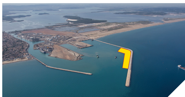
Zone identifiée pour le stockage d'éoliennes flottantes (zone interne)
