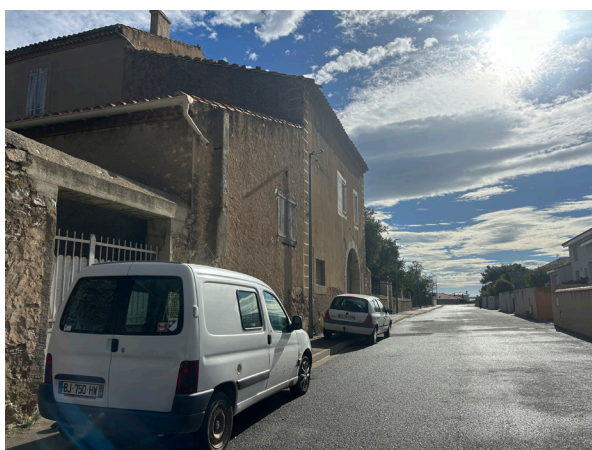
Vue maison de maître, rue Roumanille
