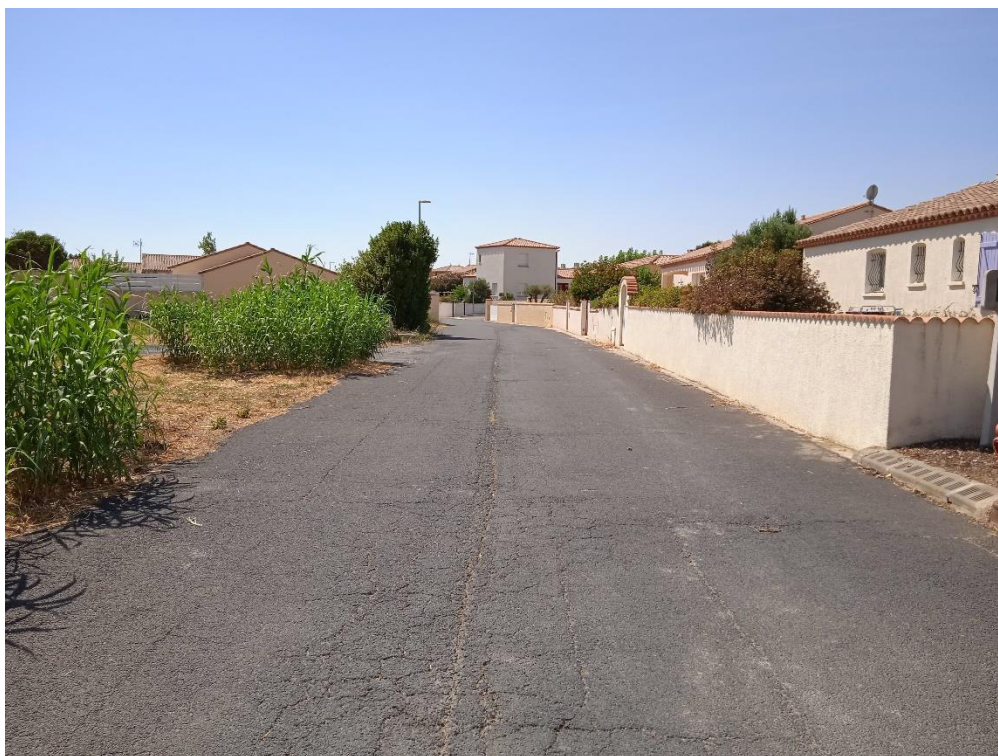
Figure 18 : Vue de la rue du Pradel, dégradé en son centre par l'érosion
