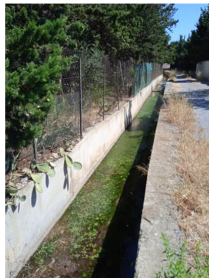
Figure 17 : Vue du fossé central dans sa partie aval : présence d'eau stagnante
