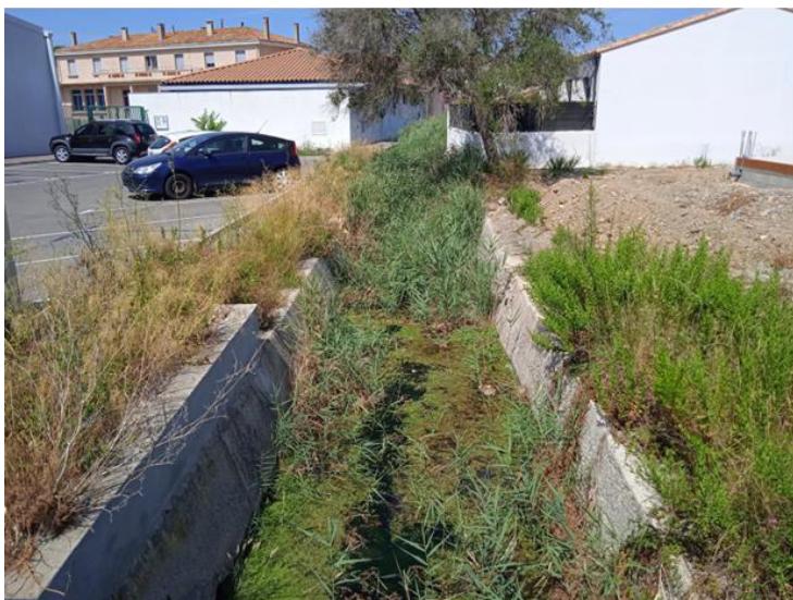
Figure 17 : Vue du fossé central dans sa partie aval : présence d'eau stagnante
