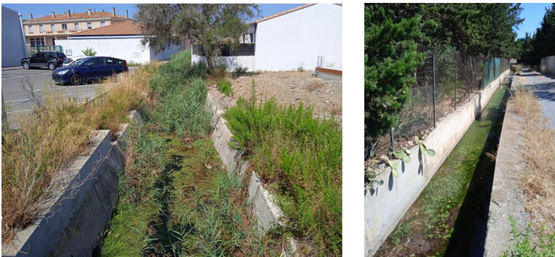
Figure 8 : Vue du fossé central dans sa partie aval : présence d'eau stagnante
